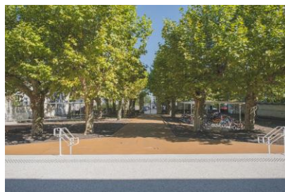
L'extension et la réhabilitation du groupe scolaire Lapie : 1 872 k€
