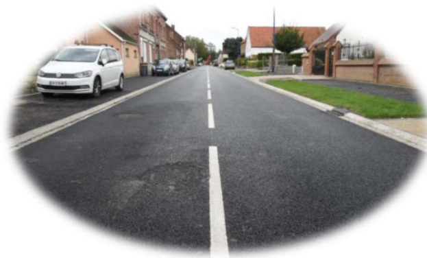
Voirie en enrobé noir
