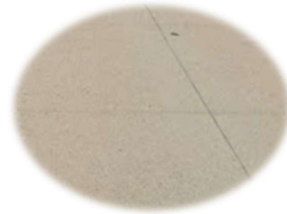
Trottoir/quai bus en béton désactivé clair
